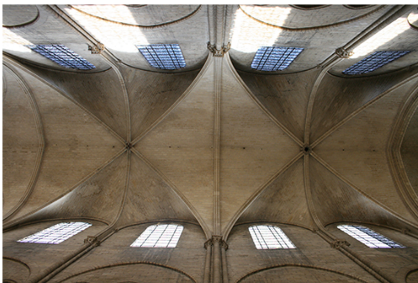
Figure 3 : Mantes-la-Jolie, collégiale Notre-Dame, vers 1170-1175 ?, voûte de la nef (cliché : A. Warie).
